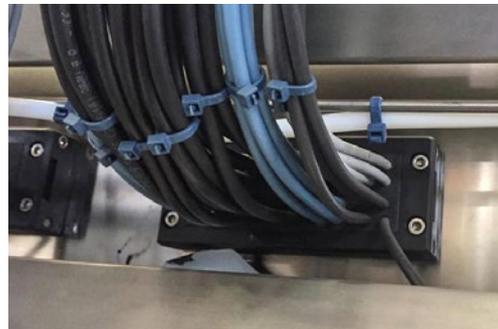
Das DES 24 Kabeleinführungssystem besteht aus einem teilbaren Rahmen, kleinen (SPP), mehrfach (X) oder großen (SPG) Kabeltüllen, welche im gleichen Rahmen Platz finden.
